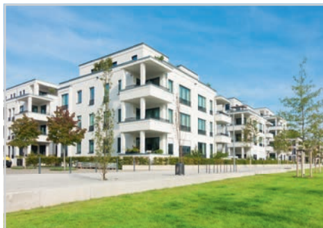
Ein- und Mehrfamilienhäuser mit ungünstiger PV-Dachsituation
