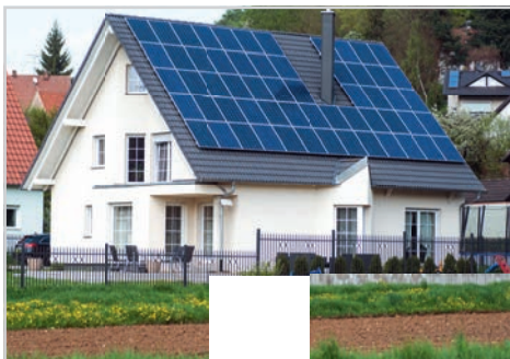
Einfamilienhäuser mit PV-Volleinspeiseanlagen
