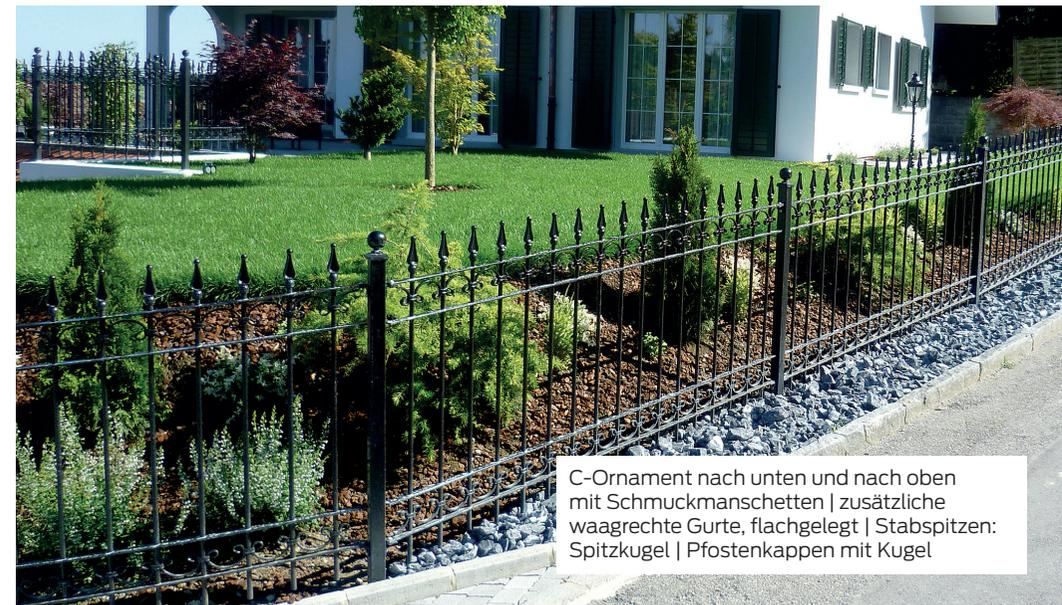
C-Ornament nach unten und nach oben mit Schmuckmanschetten | zusätzliche waagrechte Gurte, flachgelegt | Stabspitzen: Spitzkugel | Pfostenkappen mit Kugel
