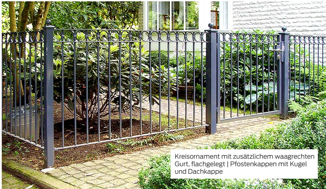
Kreisornament mit zusätzlichem waagrechten Gurt, flachgelegt | Pfostenkappen mit Kugel und Dachkappe
