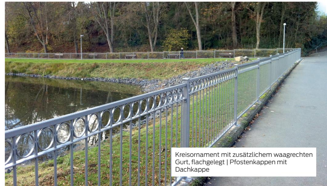
Kreisornament mit zusätzlichem waagrechten Gurt, flachgelegt | Pfostenkappen mit Dachkappe
