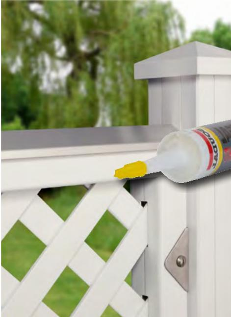
Designaufsatz Alu mit MS-Polymer-Kleber (1398) befestigen.
