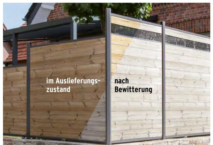
UV-Strahlung führt bei Thermoholz zu einem schnellen und natürlichen Vergrauungsprozess. Wenn Sie sich gegen diese silbergraue „Patina“ entscheiden, sollten Sie idealerweise vor der Montage die Oberflächen mit einem braunpigmentierten und geeigneten Holzschutz-Öl behandeln, um so den Grundcharakter des Zaunelements zu erhalten., z. B. WOCA Exterior Wood Oil, Farbton Teak, Art.-Nr. 0287
