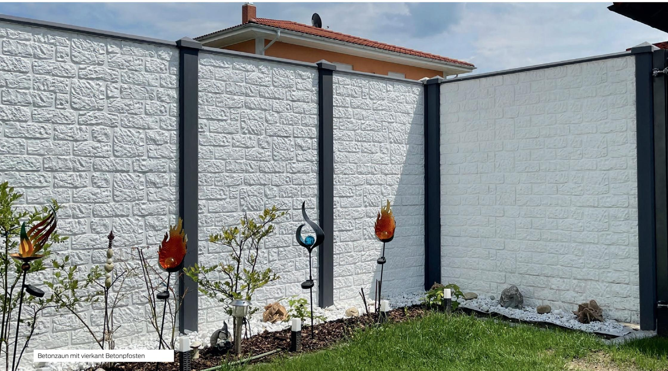
Betonzaun mit vierkant Betonpfosten
