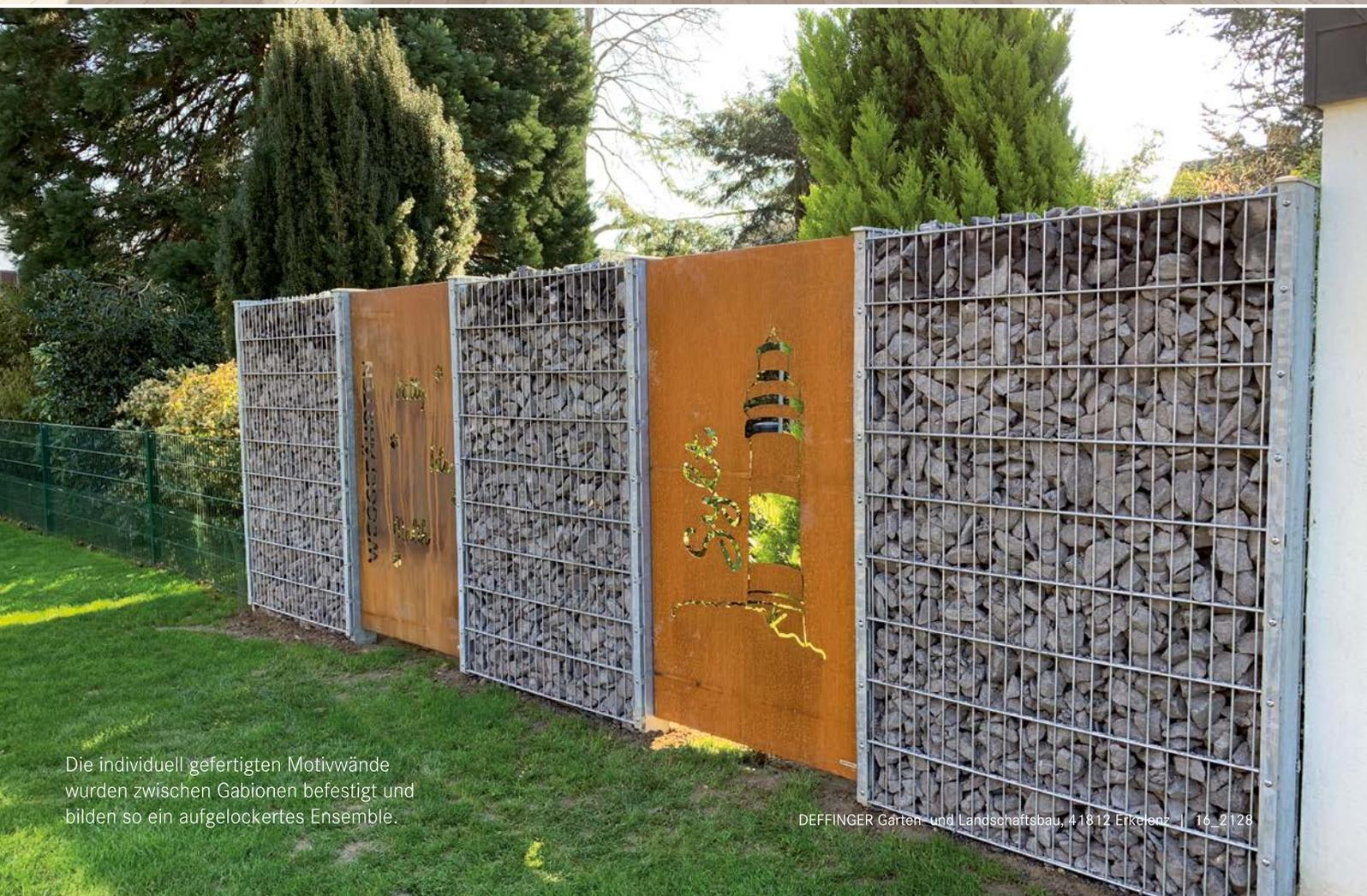
Die individuell gefertigten Motivwände wurden zwischen Gabionen befestigt und bilden so ein aufgelockertes Ensemble.
