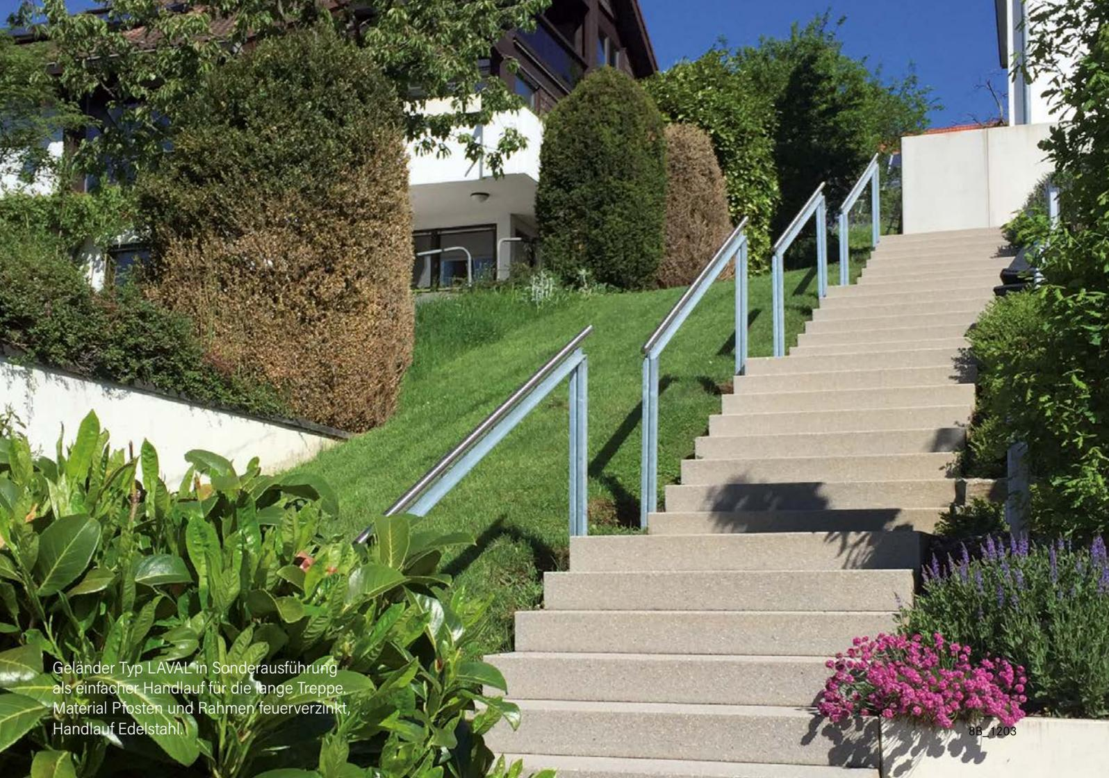
Geländer Typ LAVAL in Sonderausführung als einfacher Handlauf für die lange Treppe. Material Pfosten und Rahmen feuerverzinkt, Handlauf Edelstahl.
