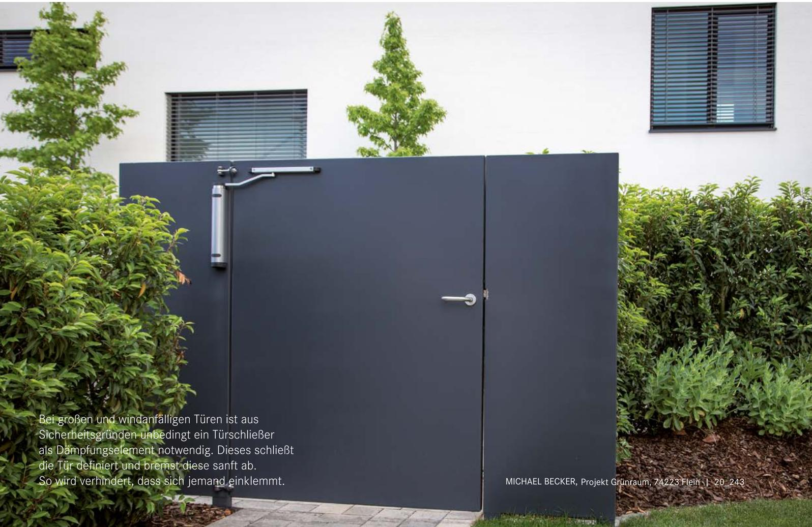
Bei großen und windanfälligen Türen ist aus Sicherheitsgründen unbedingt ein Türschließer als Dämpfungselement notwendig. Dieses schließt die Tür definiert und bremst diese sanft ab. So wird verhindert, dass sich jemand einklemmt.
