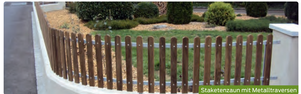
Staketenzaun mit Metalltraversen
