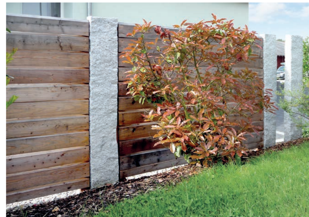
Bohlensichtschutz aus Lärche natur gehobelt, an Granitstelen montiert mit Zwischenraum (Spezialanfertigung)
