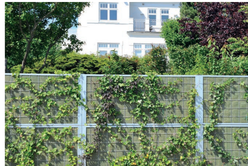
Begrünbarer Schallschutz „Noistop Steel“ mit geeigneter Oberfläche als Spalier für Kletterpflanzen
