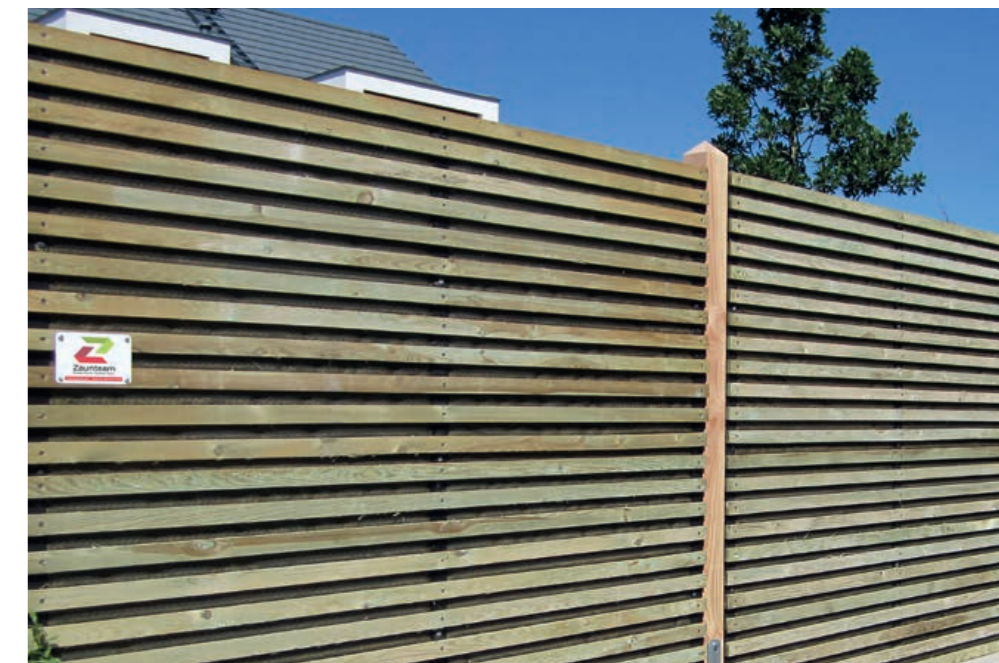
Sicht- und Lärmschutz aus druckimprägniertem Kiefernholz mit effektivem Steinwollkern für Ruhe und Lebensqualität
