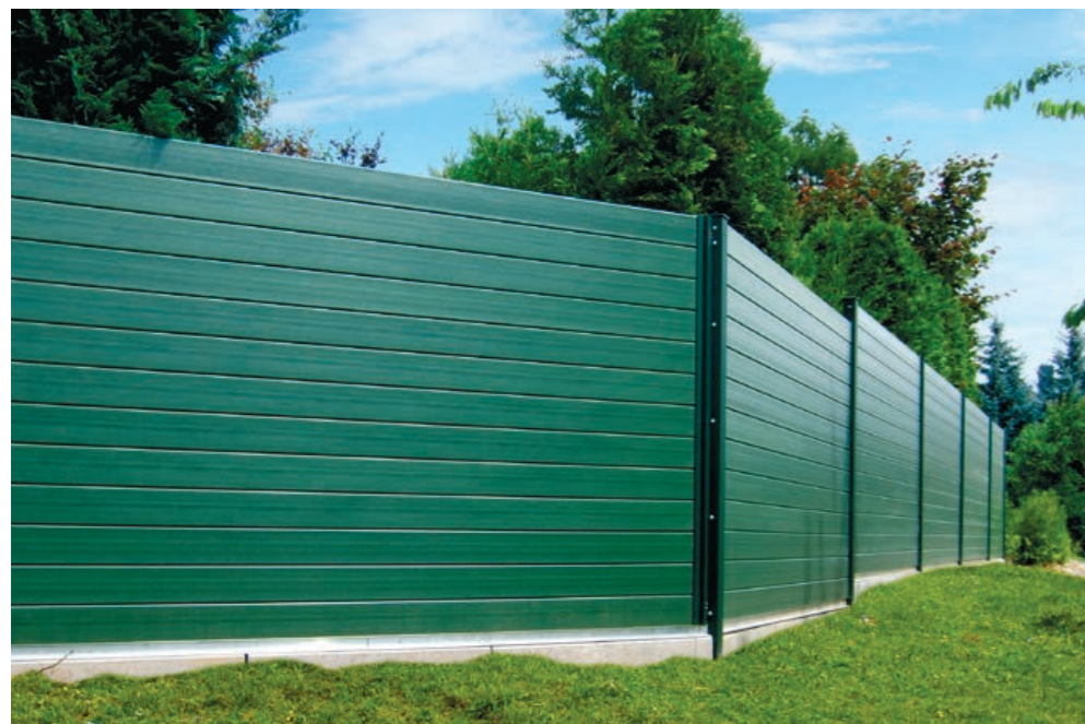
Schallschutz aus Aluminium (Typ 1): reflektierend, beidseitig mit ungelochtem Deckblech
