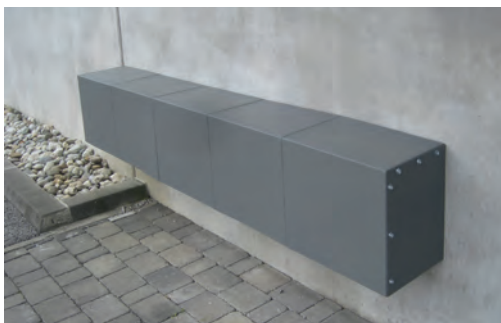
Wetterfeste Abdeckung zur Lagerung der Dammbalken
