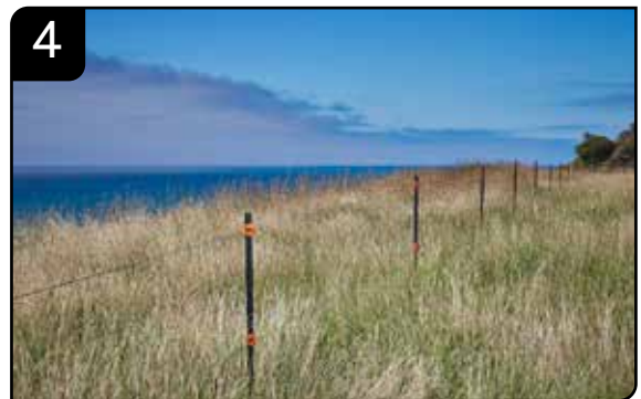
4 Stellen Sie die Zwischenpfähle auf
