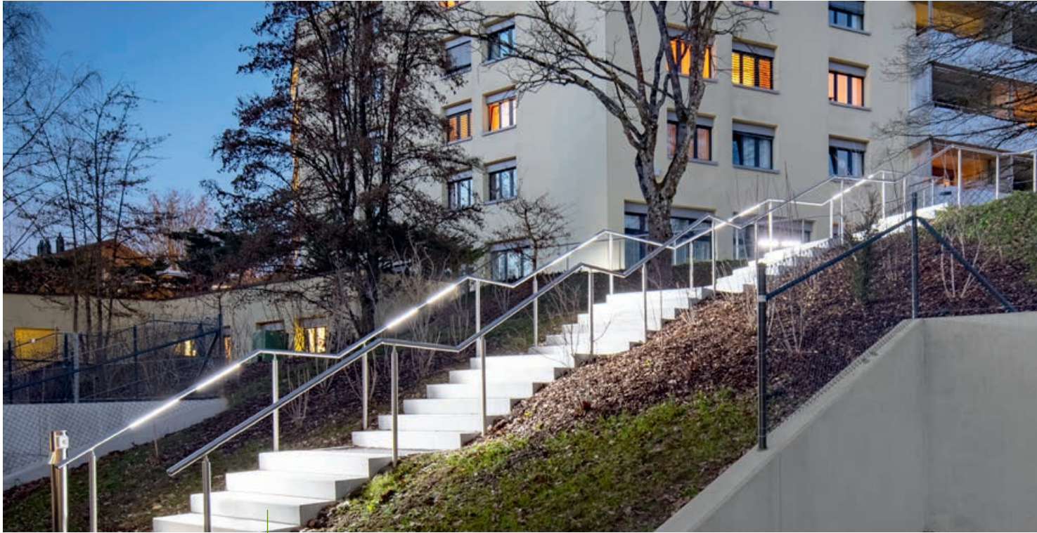
Edelstahl Handlauf, beleuchtet
