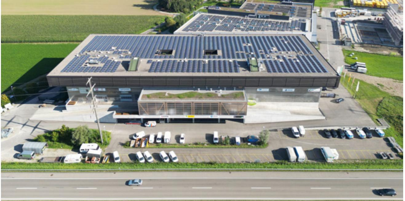
Das Gebäude der Zaunteam Zentrale in Frauenfeld ist ein Beispiel für die Verwendung von nachhaltigen, regenerativen Baustoffen. Im letzten Gebäudeausbauschritt wurden 256 m<sup>3</sup> Brettschichtholz und 280 m<sup>3</sup> Brettsperrholz (CLT) verbaut. Zudem entstand eine neue Terrasse, die wie viele anderen im Gebäude mit einer Bepflanzung ausgestattet ist.
